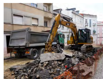
OBRAS RUA DO ALTO DO CARVALÃO PÁG.14
